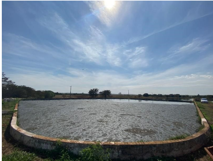
Figura 126 – Lagoa Anaeróbia (Parte 01)
