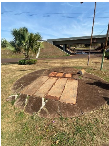
Figura 118 – Estação Elevatória de Esgoto Quinze de Setembro.
