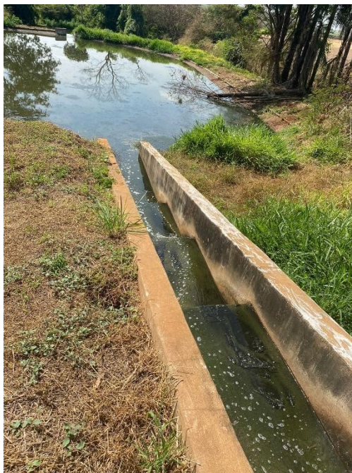
Figura 139 – Entrada do efluente na 2ª Lagoa Facultativa.
