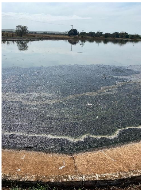
Figura 130 – Resíduos Sólidos no espelho da Lagoa Facultativa.
