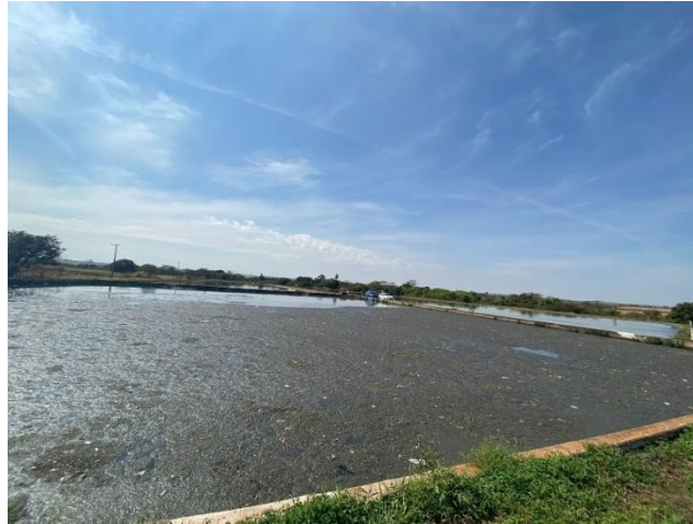
Figura 127 – Lagoa Anaeróbia (Parte 02)
