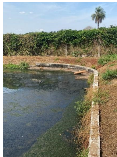
Figura 138 – Entrada do efluente na 1ª Lagoa Facultativa. (Parte 02)
