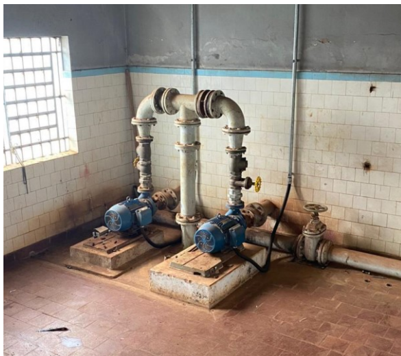
Figura 34 – Elevatórias para o poço UP06.
