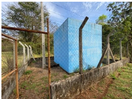
Figura 88 – Fachada Booster Itapema.
