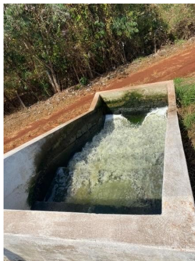
Figura 131 – Medição de Vazão na saída da ETE Guará.
