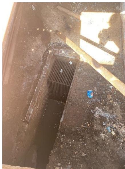
Figura 119 – Gradeamento da EEE Quinze de Setembro.
