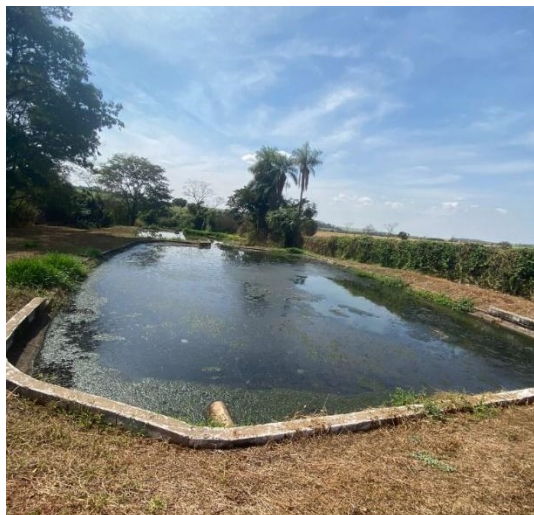
Figura 137 – Entrada do efluente na 1ª Lagoa Facultativa. (Parte 01)
